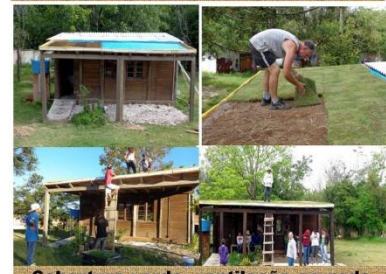
Cobertura verde, ventilação cruzada, forro de bambu, coleta de água da chuva, filtro de água cinza, espiral de ervas.
